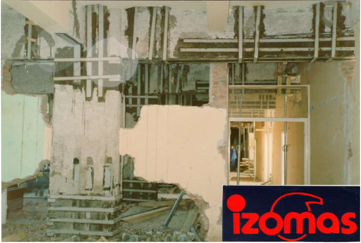
KOLON VE KİRİŞLERİN İZO-PST® PROCESS SİSTEM İLE ONARILIP DEPREME KARŞI GÜVENİLİR HALE GETİRİLMESİ
