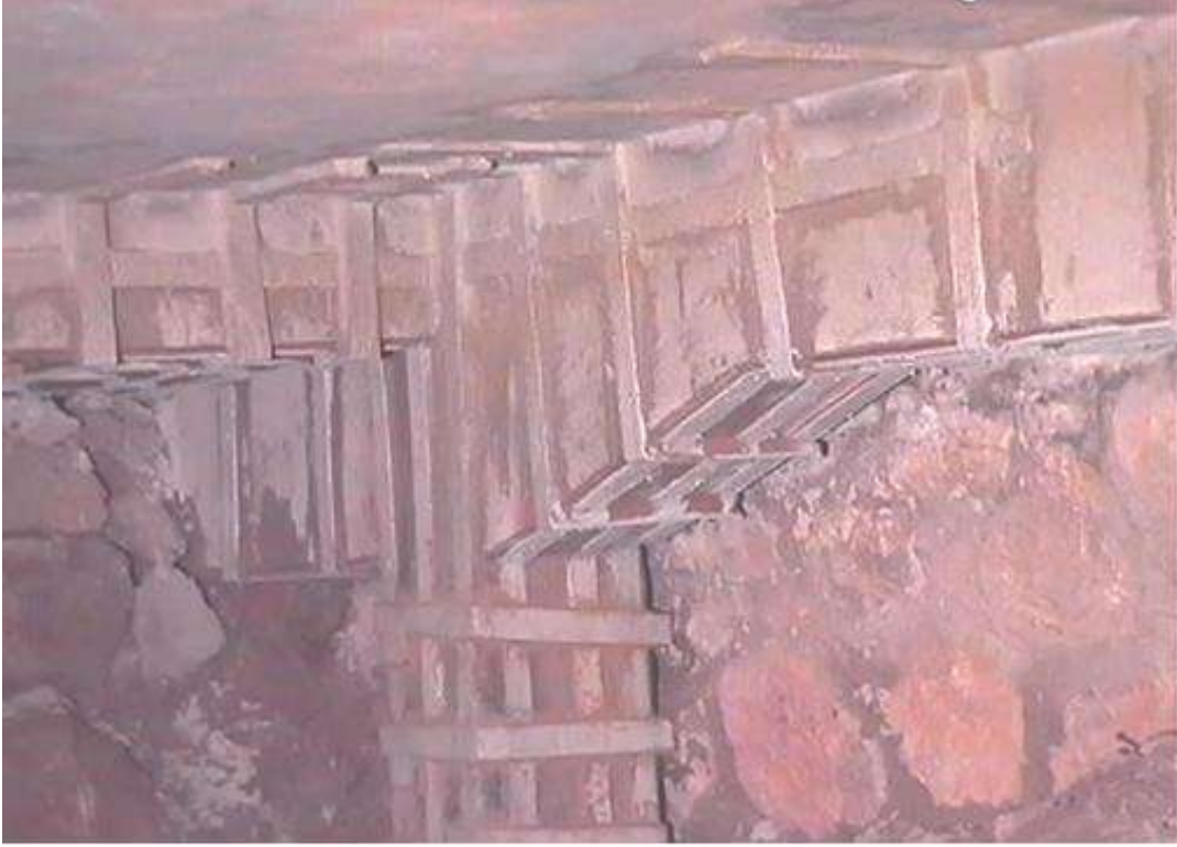
1A KOLONUNDAKİ STATİK TAKVİYE
