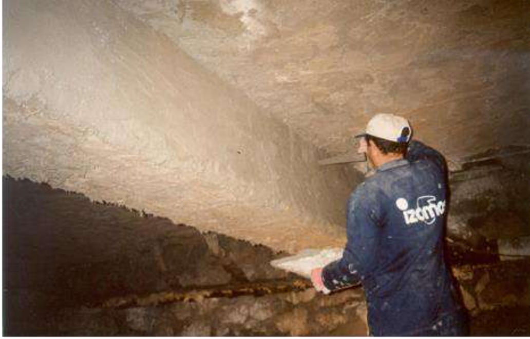
İZOMET-BRM TAMİR HARCİ İLE ESKİ GEOMETRİSİNE GETİRİLMİŞ KİRİŞ
