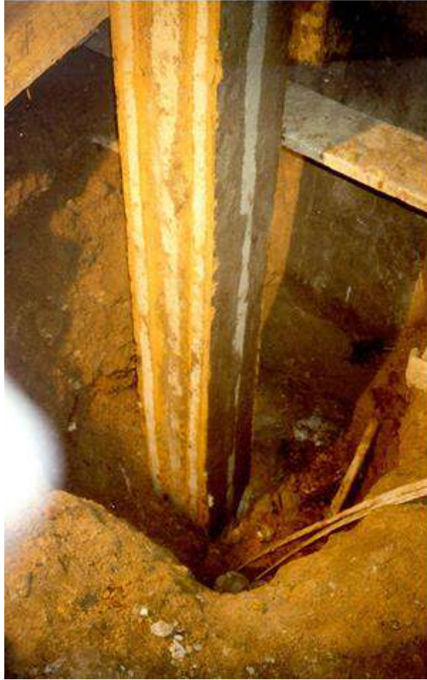
İzo-PST® PROSES SİSTEMİ İLE TEMELE KADAR YAPILAN GÜÇLENDİRME
