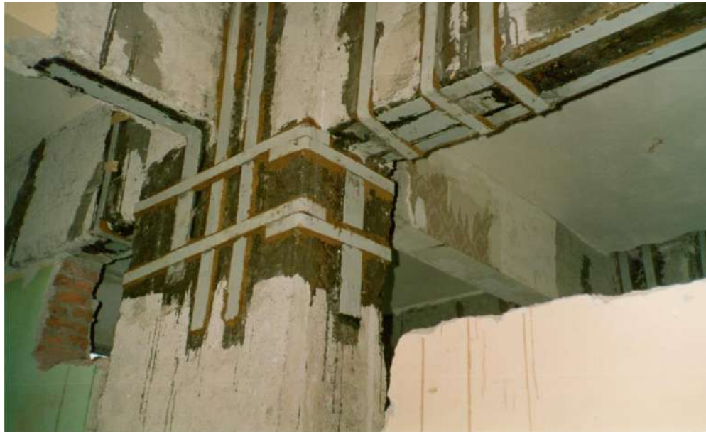
DEPREMDEN AĞIR HASAR GÖRMÜŞ BİNALARDA İZO-PST® PROSES SİSTEMİ İLE ONARIM
