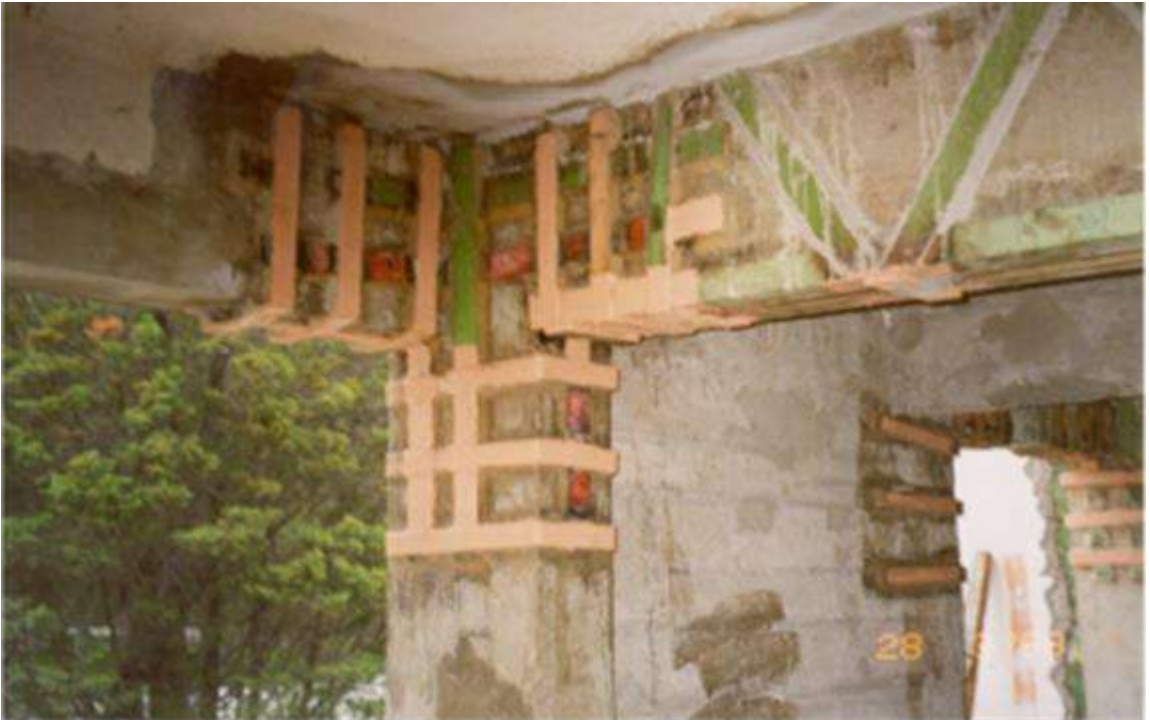
DÜĞÜM NOKTALARINDA İZO-PST® PROCESS SİSTEM UYGULAMASI
