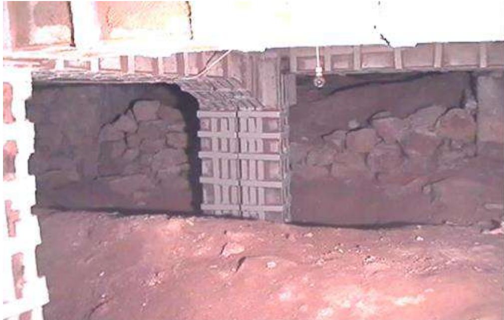
DİLATASYON AKSI KOLONLARINDA TAKVİYE DETAYI
