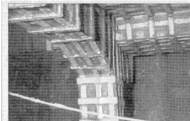
Çökme tehlikesi altında bulunan Aslanlı Yol altındaki galerilerin bir bölümü takviye edildi.
