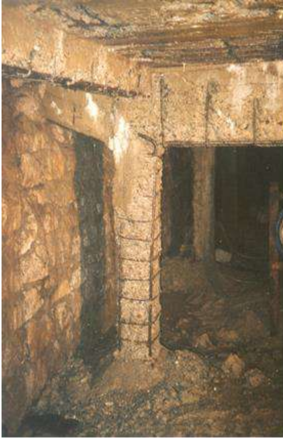
KOROZYONDAN ARINDIRILAN DONATILARIN EPOKSİ İLE KAPLANMASI
