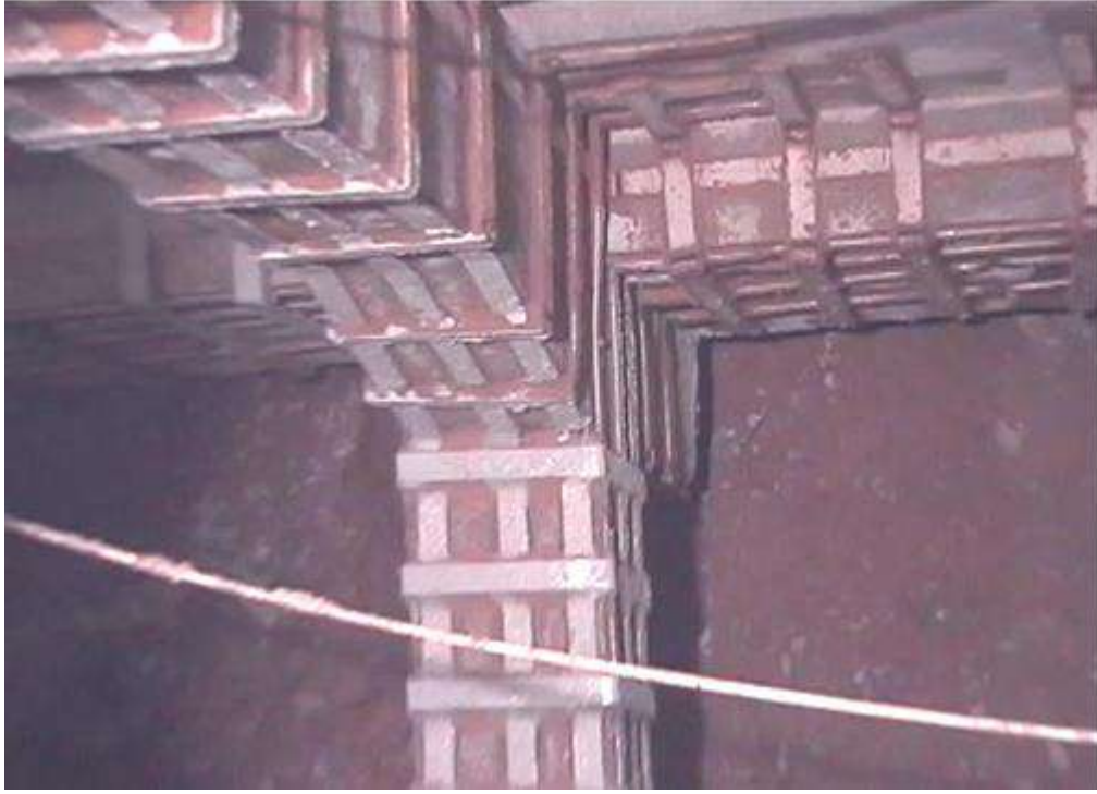
A VE D DÜĞÜM NOKTALARINDAKİ TAKVİYE
