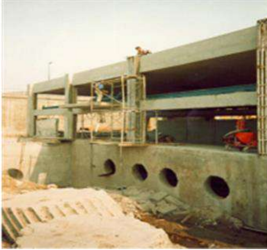
KOLONLARIN İZO-PST® PROSESS SİSTEMİ İLE TAKVİYESİ
