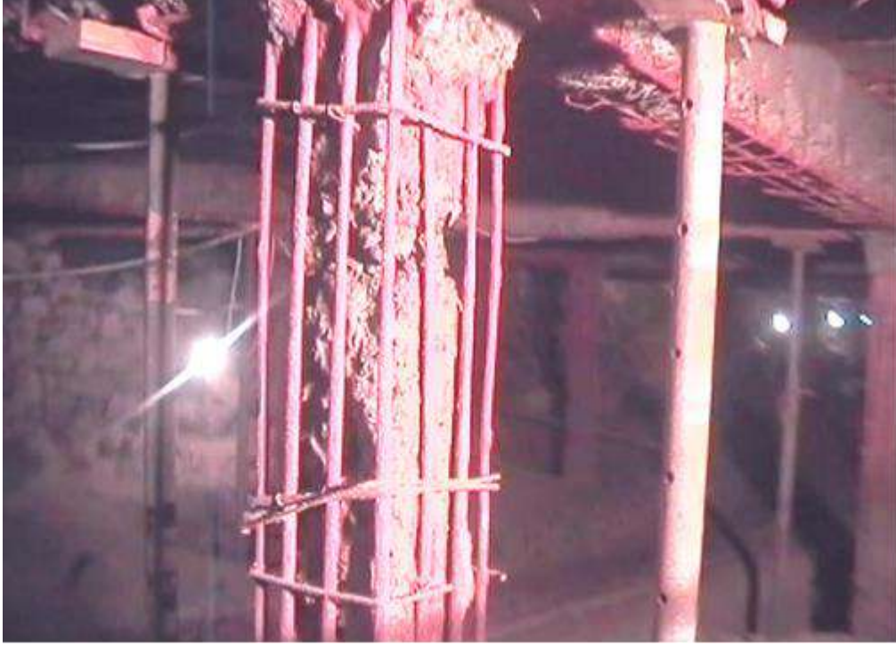
EPOKSİ İLE KAPLANMIŞ 13C KOLONU DONATILARI
