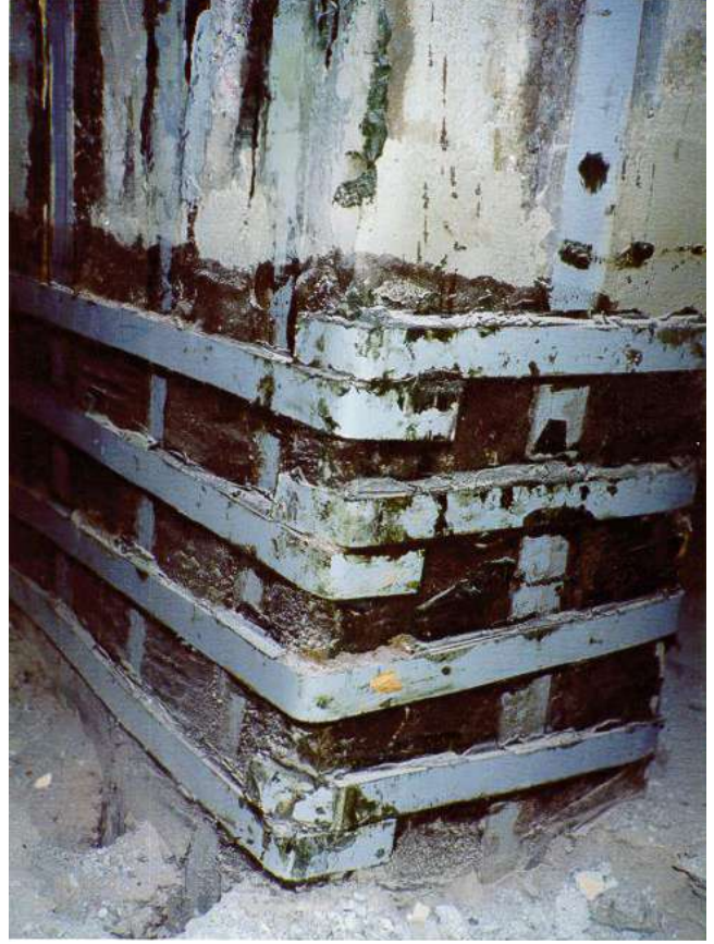
EPOXY ADHESİVE İLE YAPIŞTIRILAN ÇELİK BANTLAR
