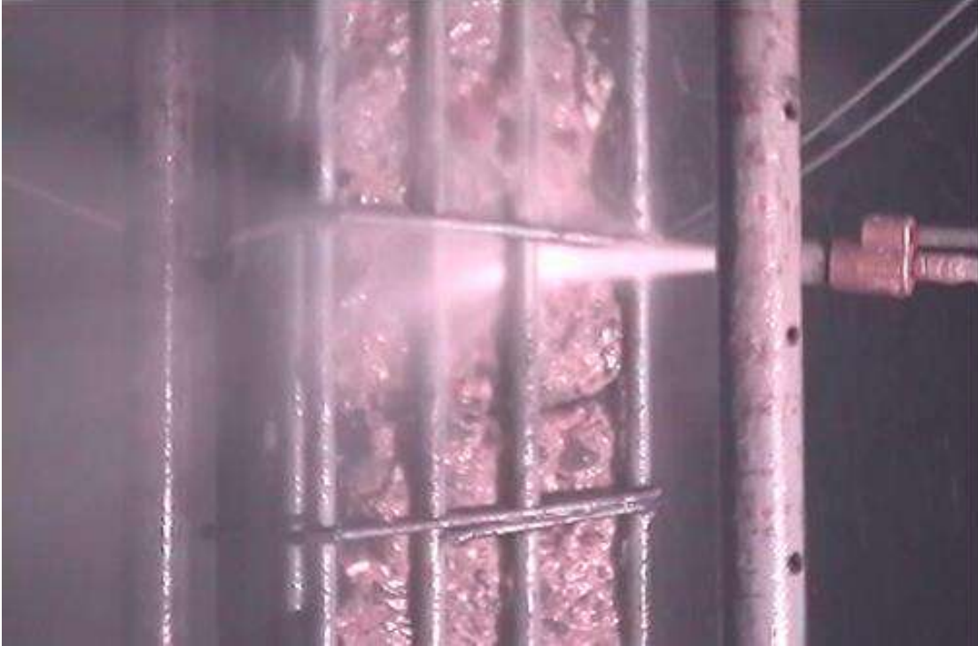
WATER-JET İLE DONATILARIN TEMİZLENMESİ
