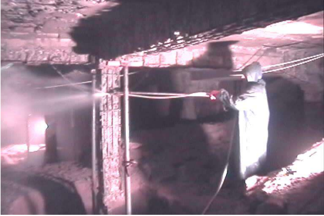
WATER-JET İLE DONATILARIN TEMİZLENMESİ
