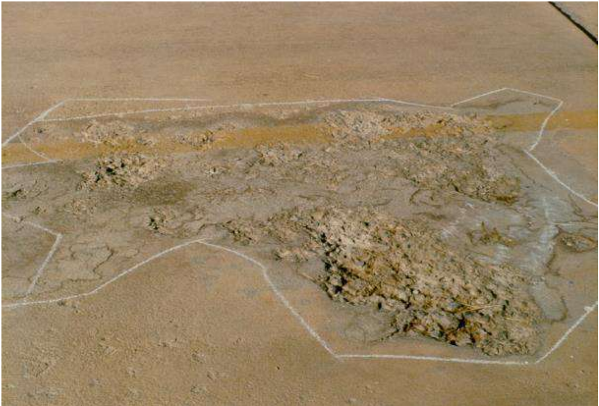
EPOXY ENJEKSİYON VE REPAIR MORTAR İLE PİST ONARIMI
