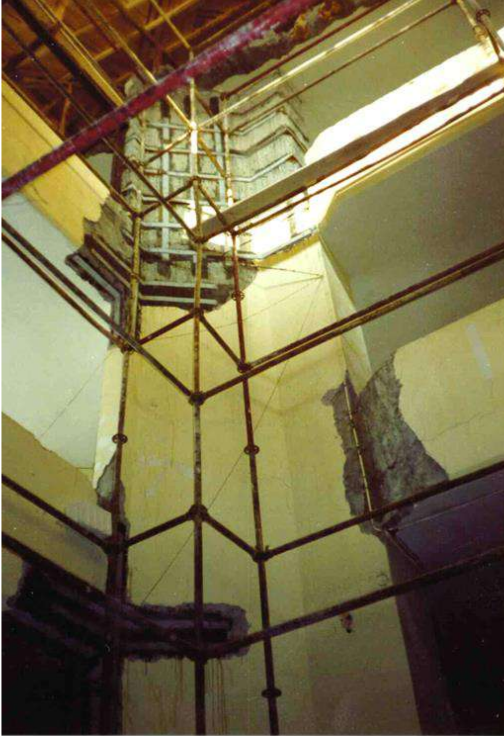
DEPREMDEN HASAR GÖRMÜŞ ELEMANLARIN İZO-PST® İLE ONARIM VE GÜÇLENDİRİLMESİ
