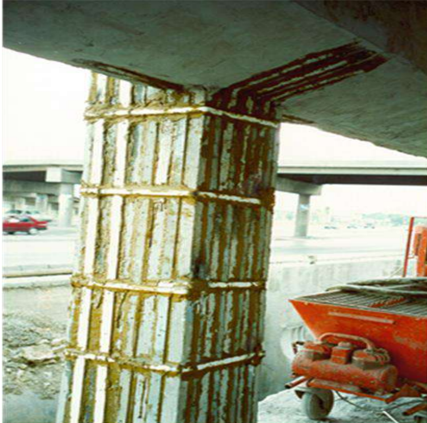
KOLONLARIN İZO-PST® PROSESS SİSTEMİ İLE TAKVİYESİ
