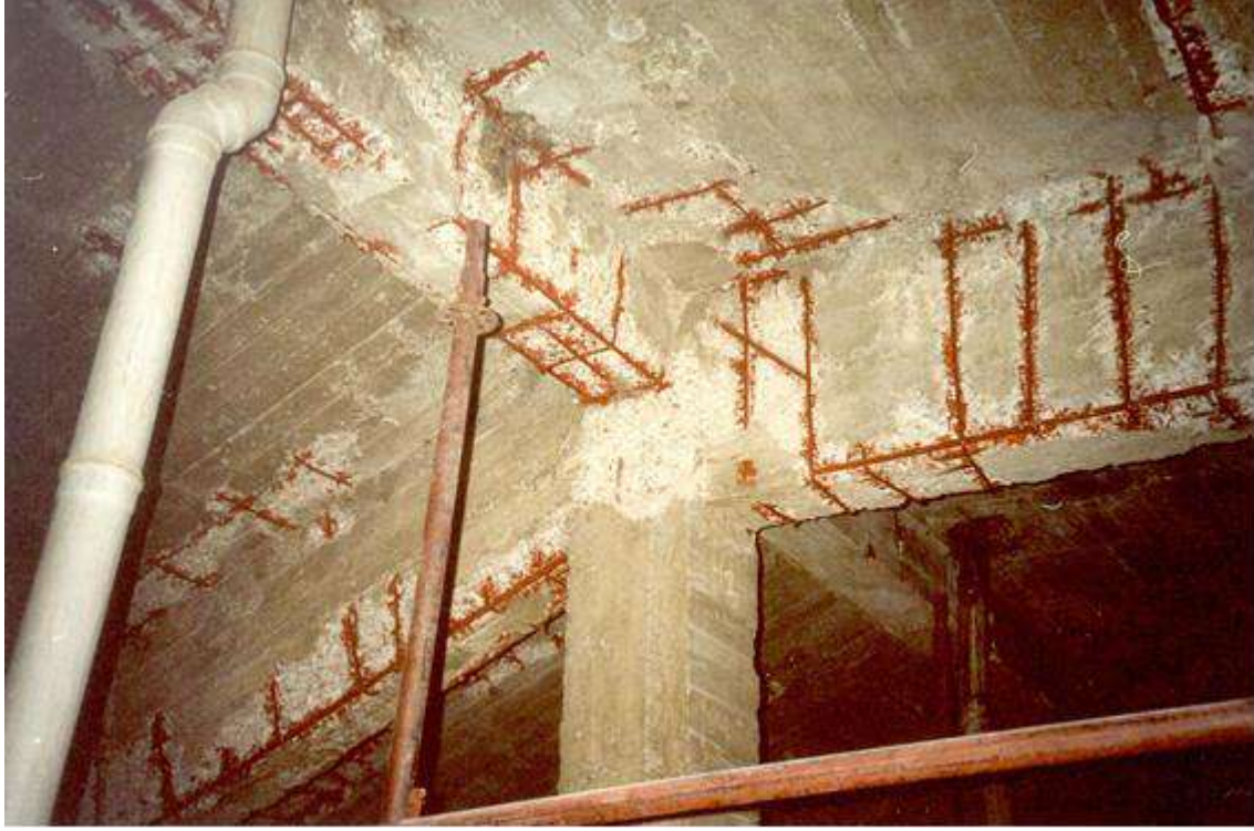
EPOKSİ İLE KAPLANAN DONATILARININ
