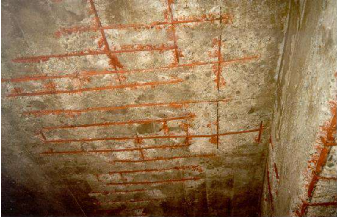
EPOKSİ İLE KAPLANAN DONATILARININ
