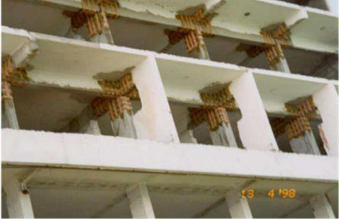
DÜĞÜM NOKTALARINDA İZO-PST® PROCESS SİSTEM UYGULAMASI
