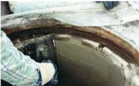
4. VANDEX RAPID S ile menhol'ün üst kısmı eski sıva düzeyine getirilir.
