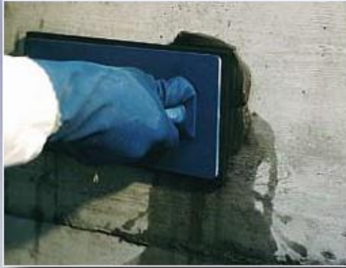
kuvvetlice deliğin içine bastrılır. (30 saniye).
