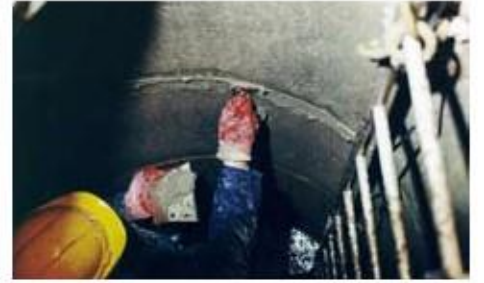
3. VANDEX RAPID M sızıntı olan derzlere uygulanır.
