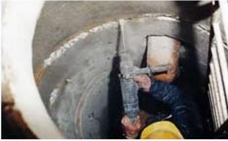
1. Çatlaklar ve derzlerin hazırlığı yapılır.
