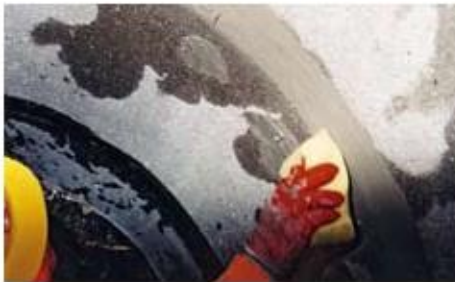
5. VANDEX RAPID S bir sünger yardımıyla düzleştirilir.
