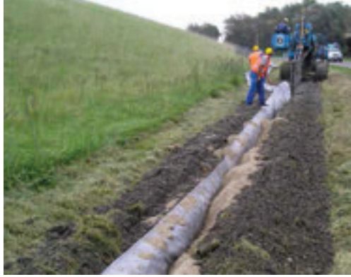
Yol inşaatlarında TechDrain ile drenaj sistemi.
