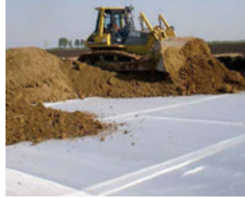
Yol yapılarında TechGrid TRC ile zemin güçlendirme ve ayırma.
