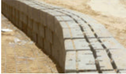
Dubai otoyolu bloklü istinat duvarı.
