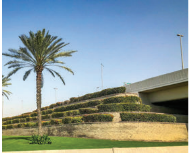
Dubai otoyolu bloklü istinat duvarı.
